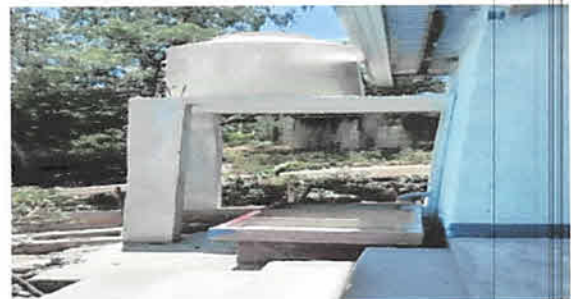
Foto 6: Instalacion del tanque de agua
