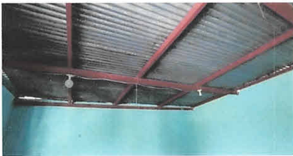
Foto 3: Cambio del sistema electrico
