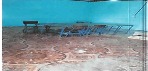
Foto 2: Instalacion de piso
