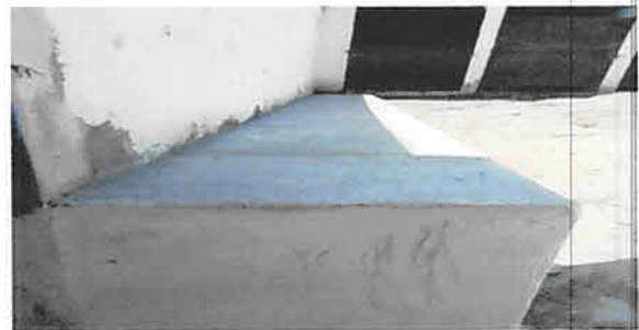
Foto 4: Elaboracion de banqueta de mamposteria
