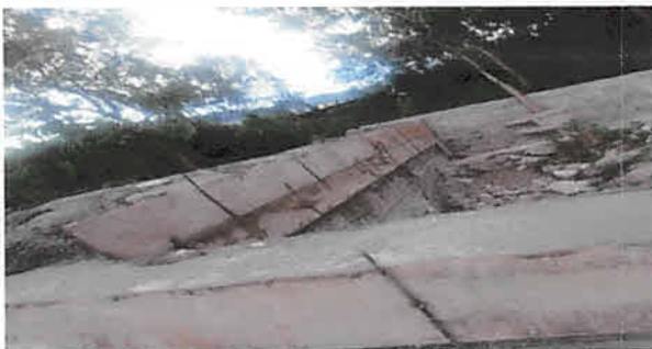
Foto 5: muro perimetral de piedra
